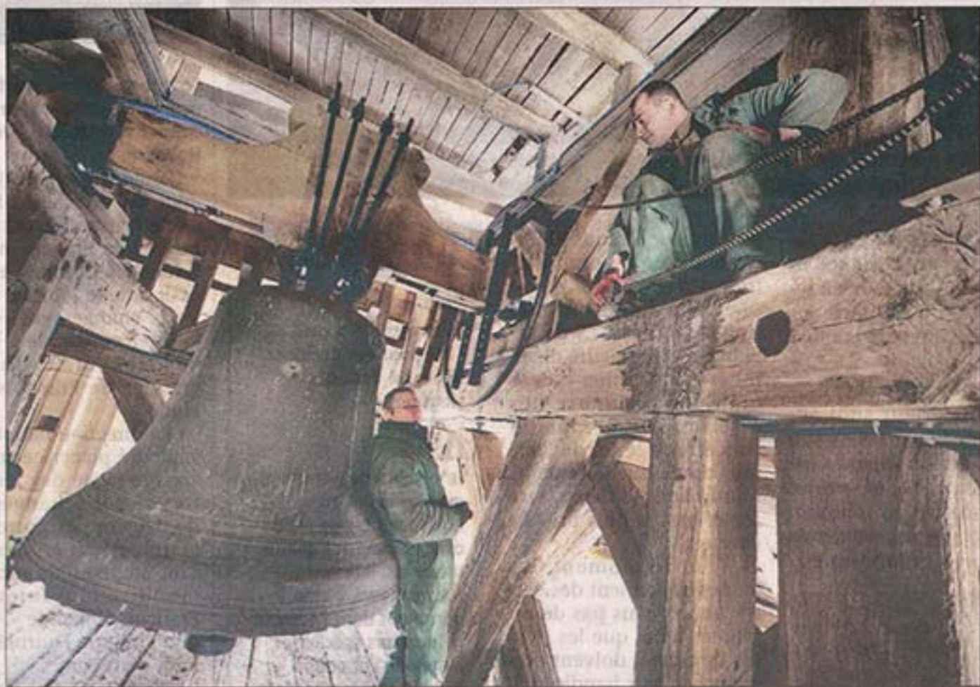
MÉCANISME. Roger Lucot et Laurent Demont, de la société Mamias, installent le mécanisme qui permettra de faire tourner la cloche. PHOTOS STÉPHANIE PARA
